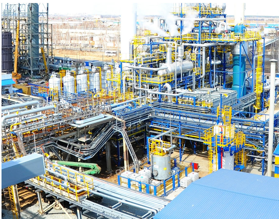
Пример технологического промышленного объекта капитального строительства Фото автора
