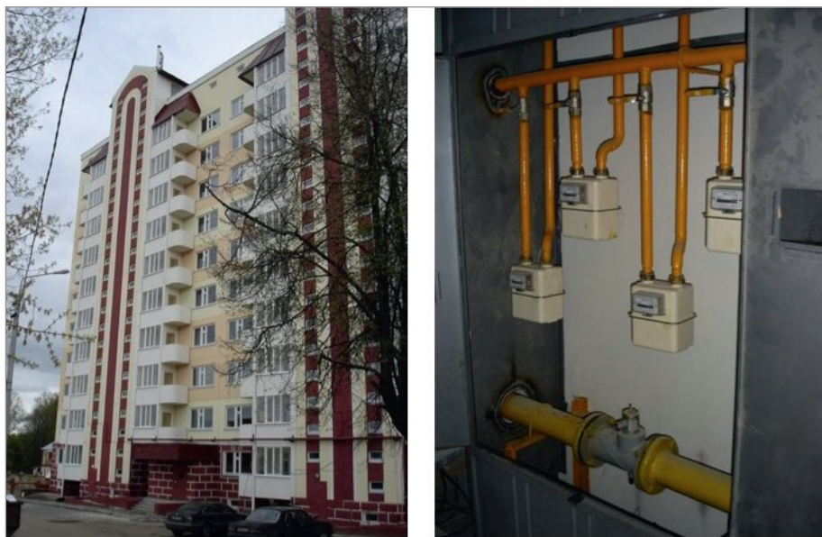
Рис. 5. Слева – дом с поквартирным теплоснабжением (г. Серпухов Московской области); справа – шкаф для размещения газовых счетчиков и отключающих устройств
