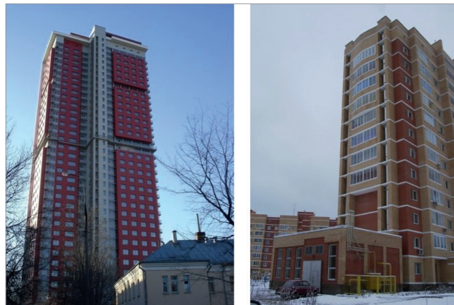
Рис. 8. Примеры домов с крышной и пристроенной котельными
