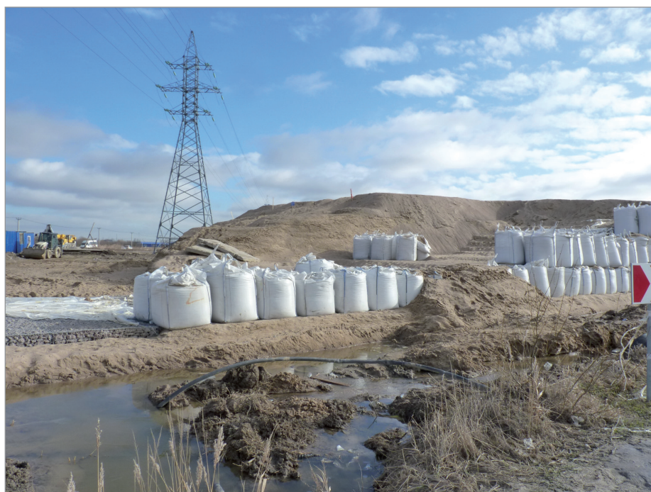
Рис. 4. Прогал в насыпи (слева – путепровод, справа – отсыпанная часть насыпи)
