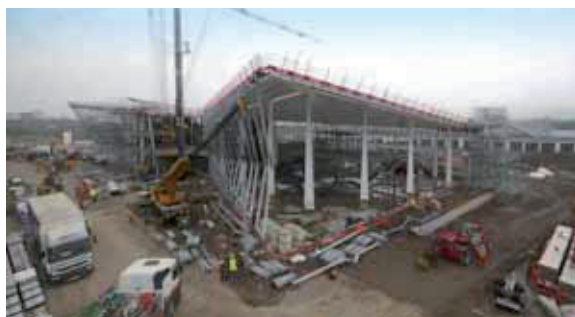
"Кристалл" на этапе строительства
