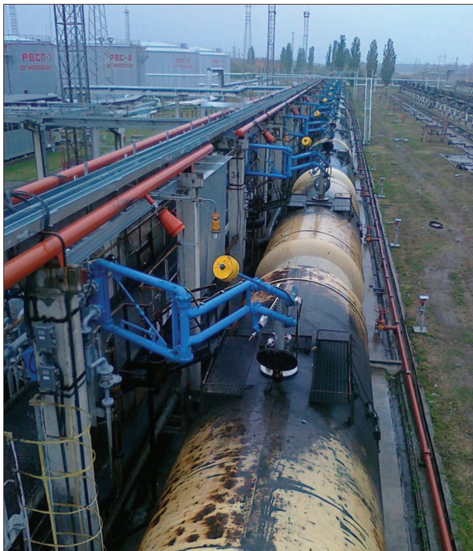
Продукция предприятия: устройство верхнего герметизированного налива в железнодорожные цистерны и эстакада с устройствами верхнего герметизированного налива (г. Тихорецк)
