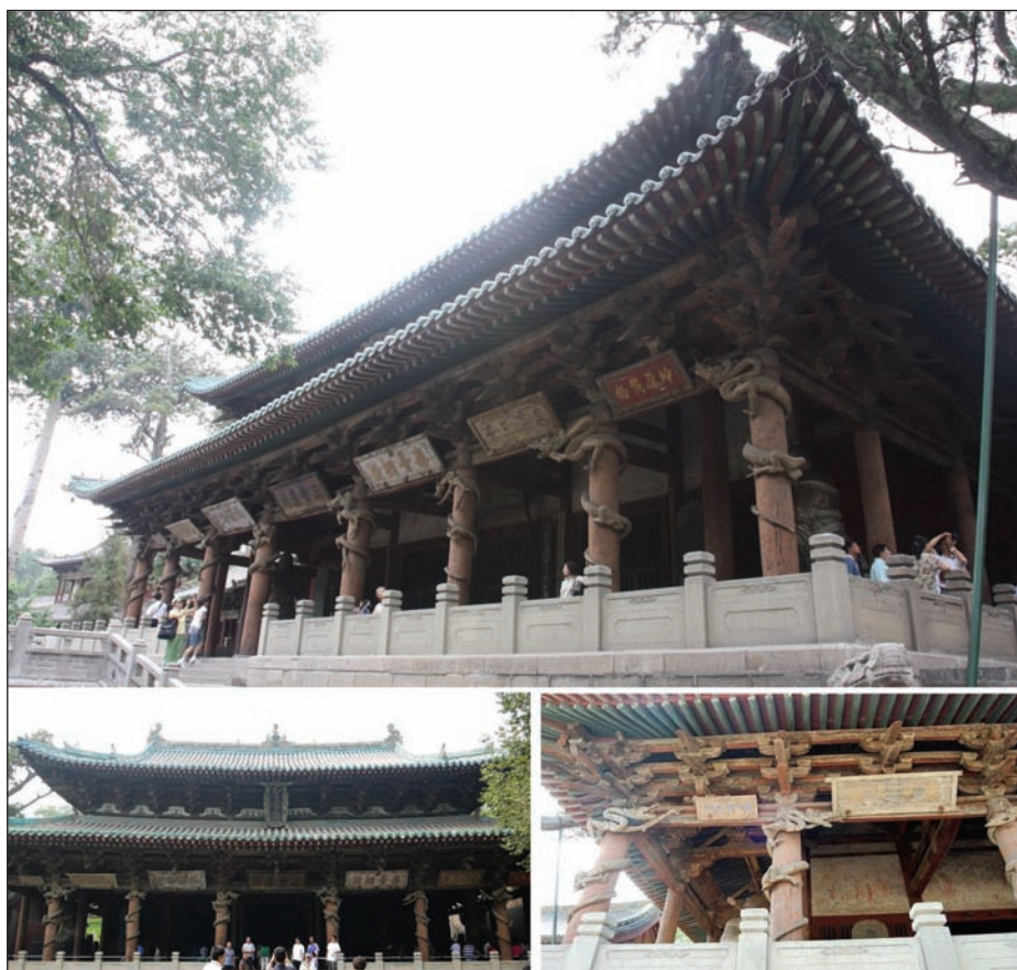
Храм Шенмудянь (1102-1106) в монастыре Цзиньцы в провинции Шаньси – один из дошедших до нас деревянных памятников архитектуры, построенных с использованием системы доугун
