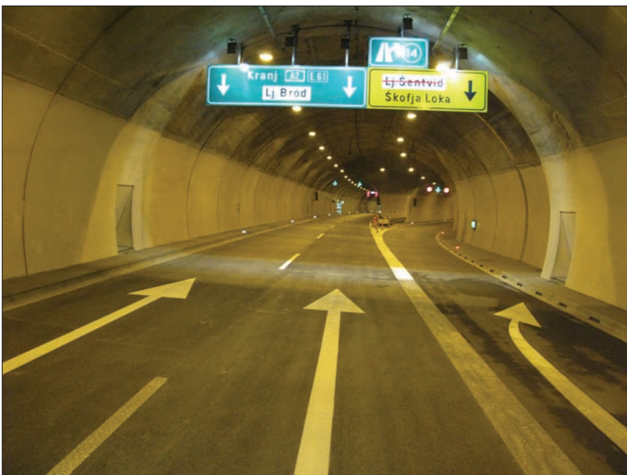
Съезд в тоннеле Шентвид
