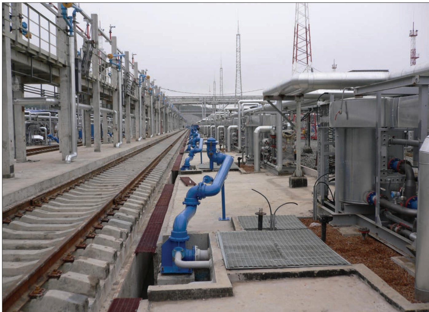
Продукция предприятия: эстакада с УСН (устройства нижнего слива) и устройствами для размыва
