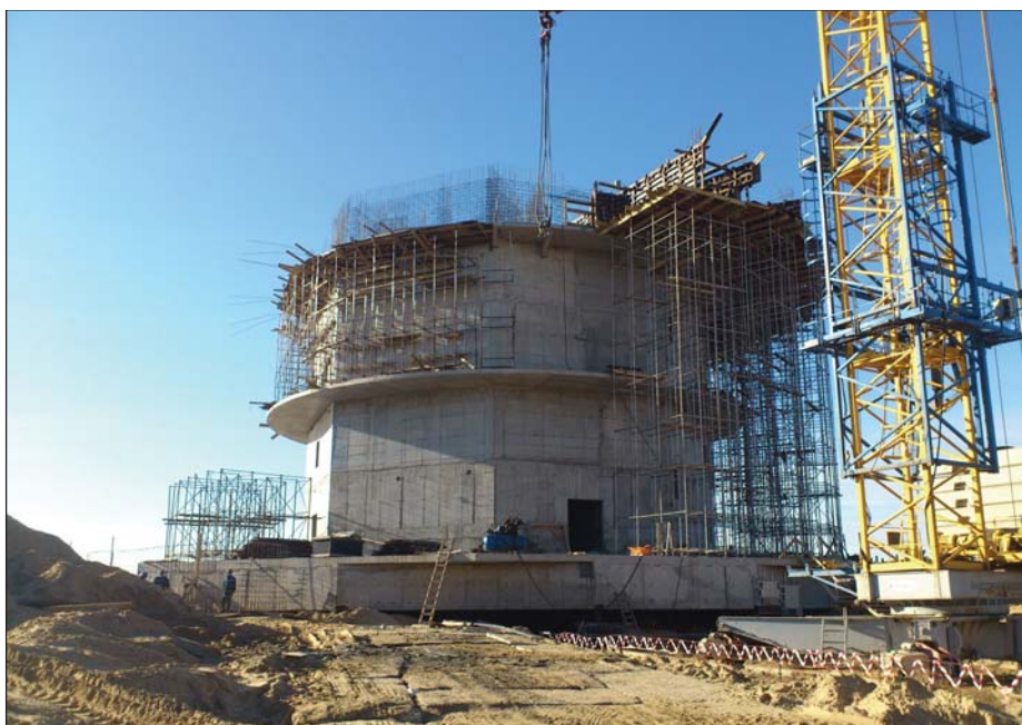
Этап строительных работ (3 октября 2012 г.)
