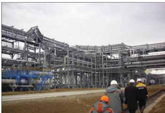
Строительная площадка ЦПС Южное Хыльчюу
