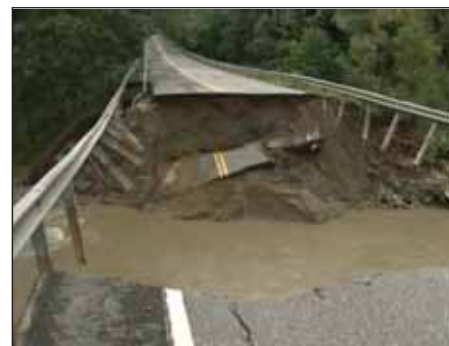
Полное разрушение насыпи через четыре минуты
