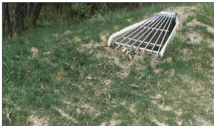
Выходящий оголовок и скаурстоп после установки
