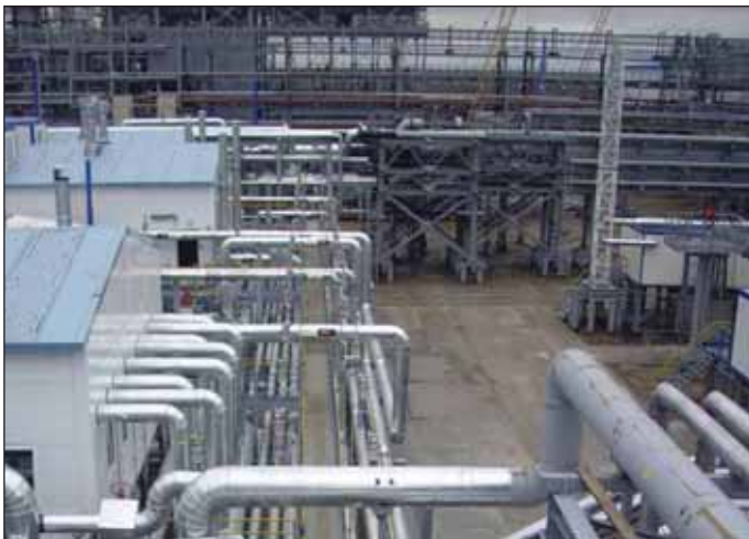
Строительная площадка ЦПС Южное Хыльчучо
