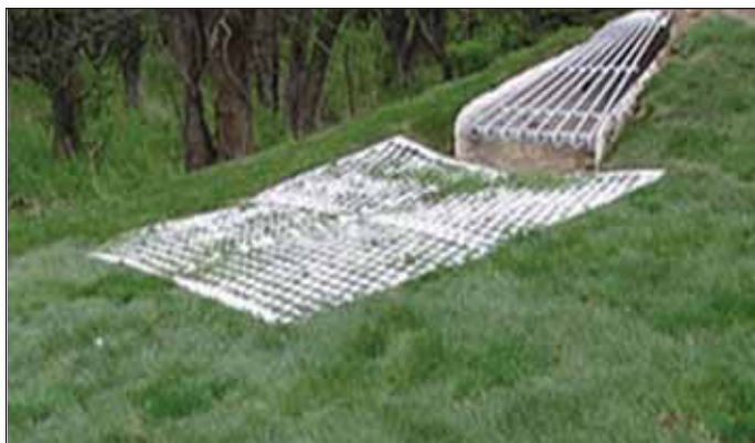
Установка блоков скаурстоп
