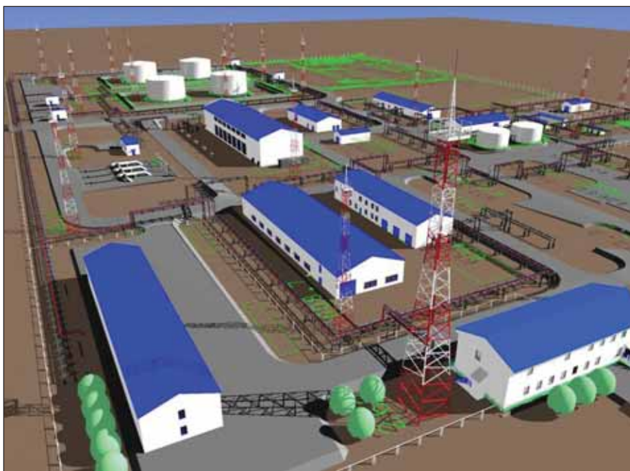
Визуализация генплана площадки НПС
