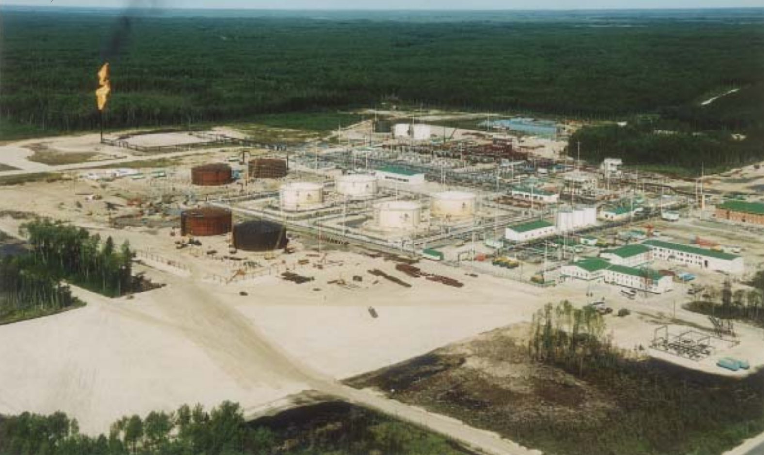
Строительство центрального товарного парка на Приобском месторождении
