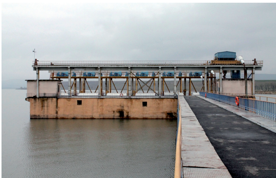
Рис. 2. Существующее здание Кубанской ГАЭС
