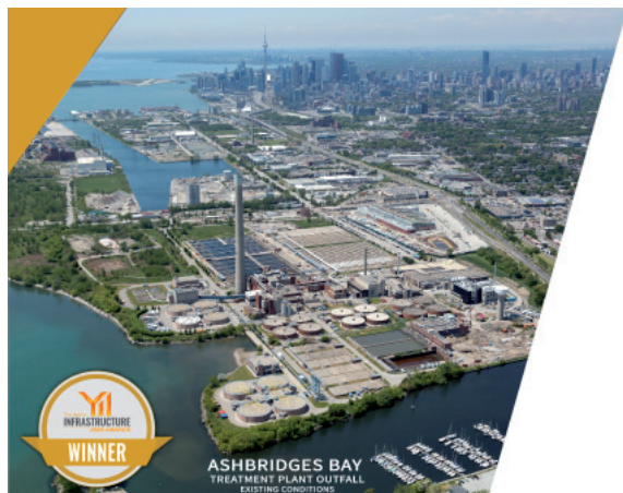
Hatch Выводной коллектор водоочистных сооружений залива Эшбриджес (Торонто, Онтарио, Канада)
