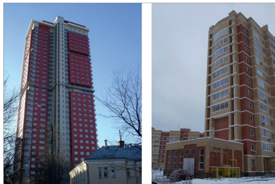
Рис. 8. Примеры домов с крышной и пристроенной котельными
