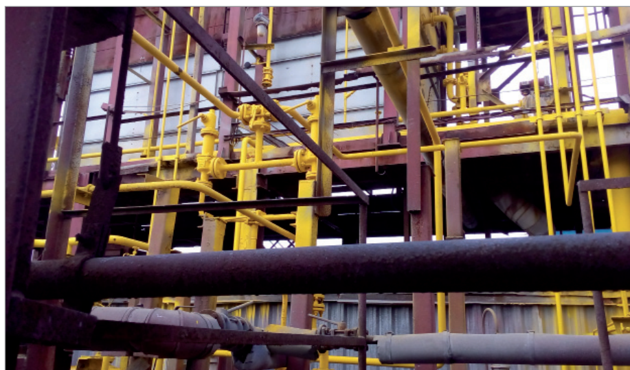
Рис. 21. Фотография объекта реконструкции, предоставленная заказчиком
