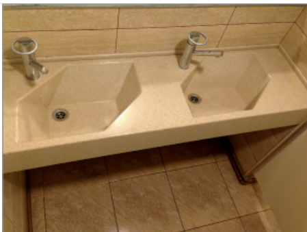
Рис. 27. Умывальник, смонтированный в проектное положение
