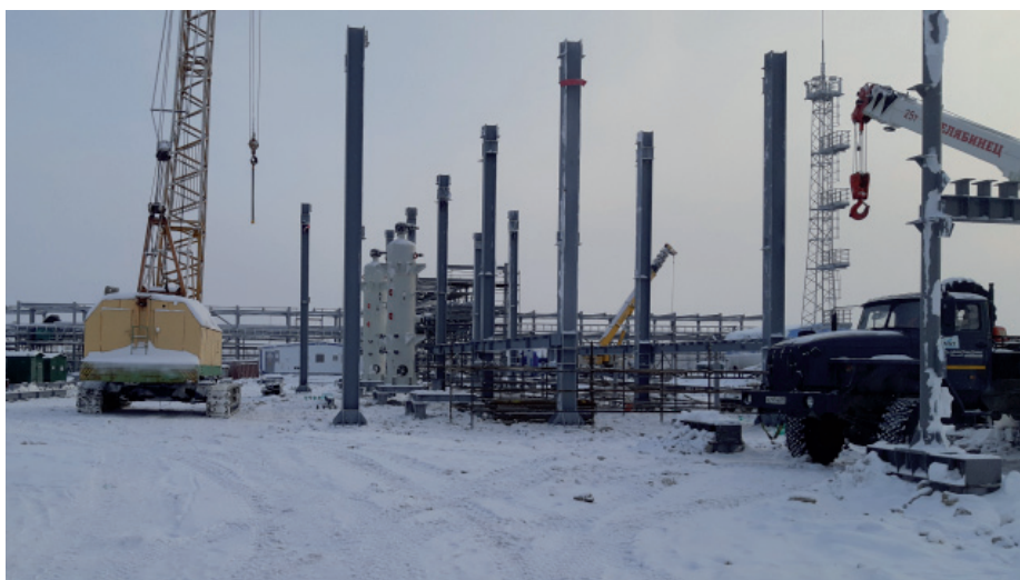
Объект находится на стадии строительства. Место расположения: Ямало-Ненецкий автономный округ
