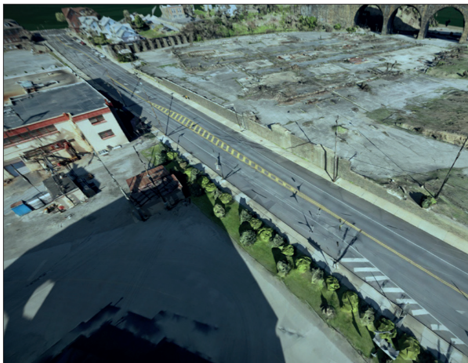
Информация, полученная с использованием ПО ContextCapture, сыграла важную роль и при определении текущего состояния объекта, и при создании планов реконструкции
