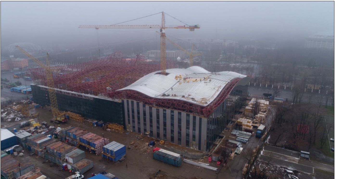
На строительной площадке
