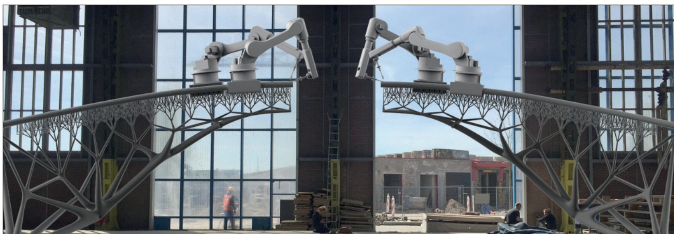
Рис. 1. Пешеходный мост через канал в Амстердаме. Проект компании MX3D
