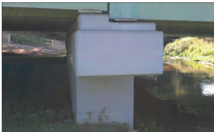
Рис. 5. Промежуточная опора № 2, вид с низовой стороны после ремонта
