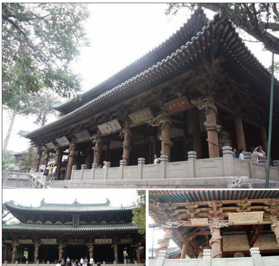
Храм Шенмудянь (1102-1106) в монастыре Цзиньцзы в провинции Шаньси – один из дошедших до нас деревянных памятников архитектуры, построенных с использованием системы доугун
