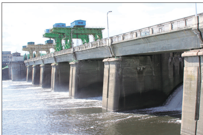
Пролетные строения моста, водосливная часть плотины, вид со стороны нижнего бьефа
