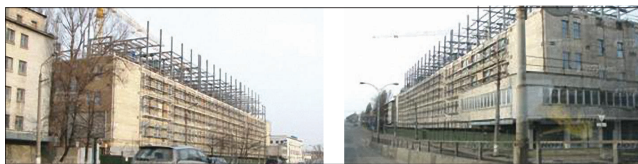
Рис. 7. Общий вид здания в процессе возведения надстройки
