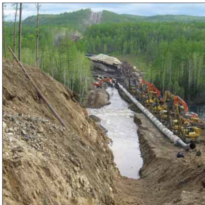
Строительство подводного перехода реки Уркан
